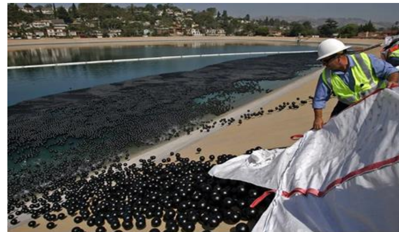
... Las bolas de sombra son pequeñas esferas de polietileno de alta densidad (HDPE) que flotan en la parte superior de un reservorio...
