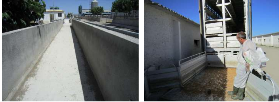
Detalle de pasillo de carga y descarga y de operario en entrada de animales
