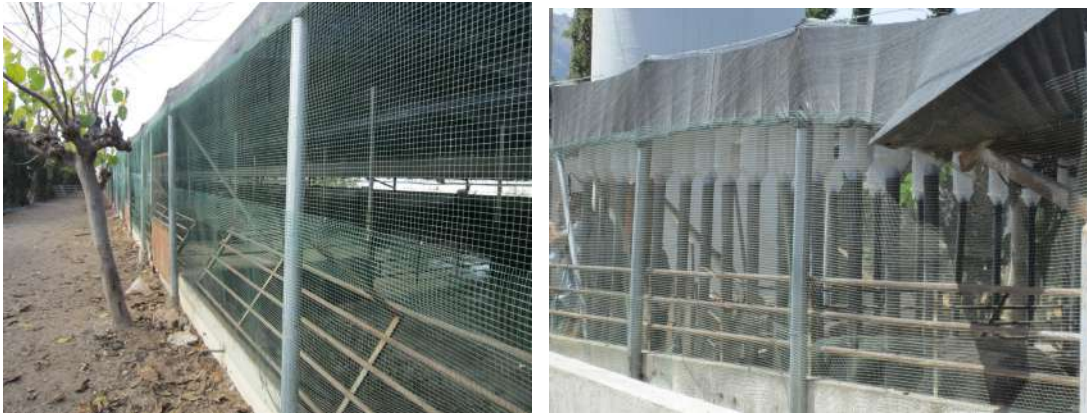
Detalle de mallas para evitar entrada de plagas
