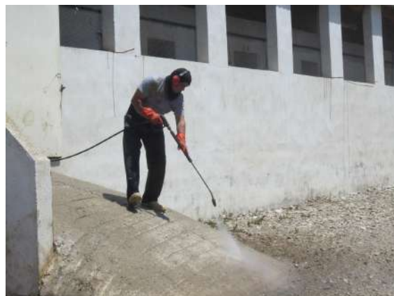
Detalle limpieza Gestión y accesos a las naves
